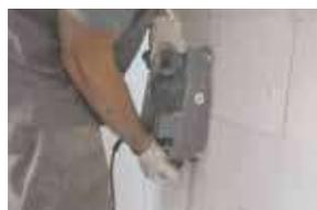
Scanalatore elettrico a fresa.
