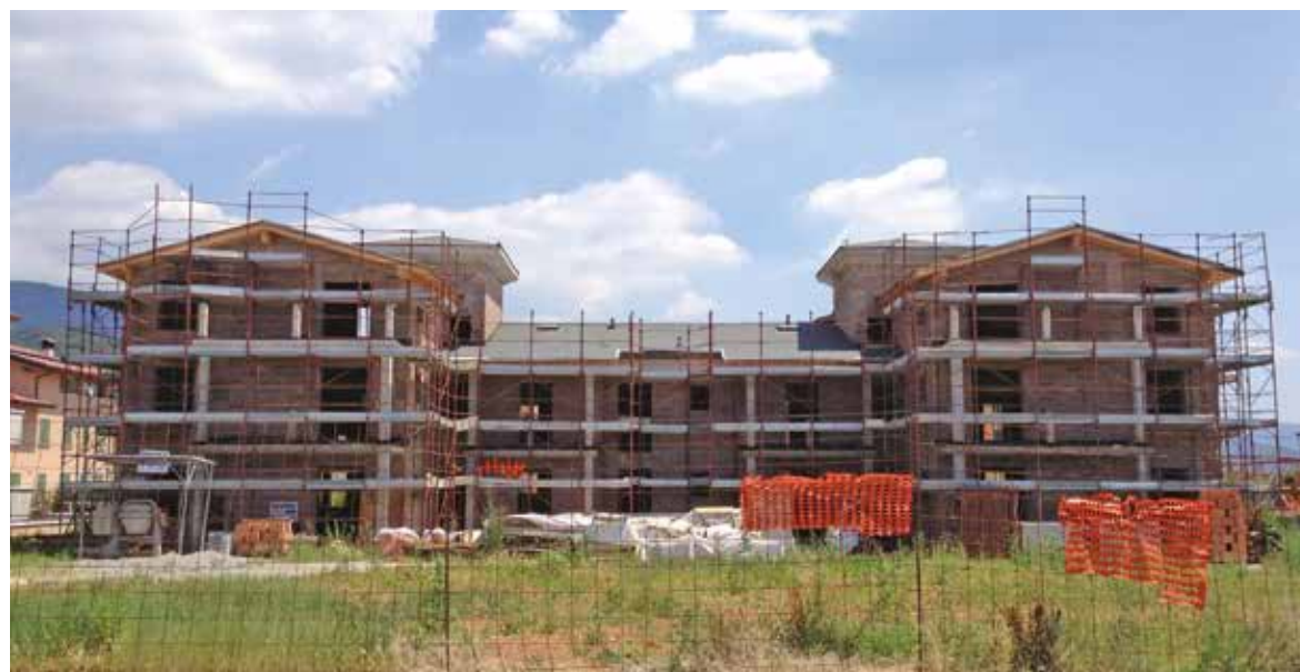
Intervento di 17 alloggi a RODENGO SAIANO (BS) - 2012
