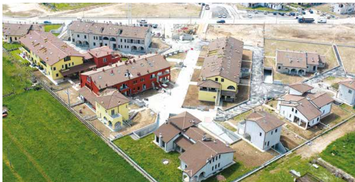
Intervento di 100 alloggi a VERONA - 2003
