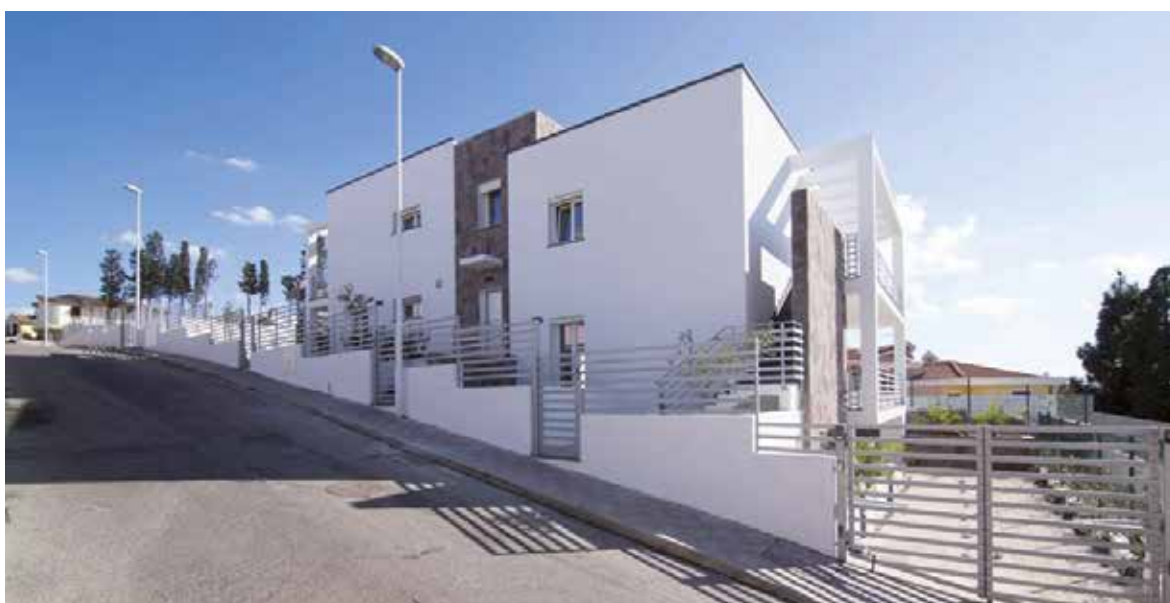
Complesso residenziale 5 alloggi a BARACCAMANNA (CA) - 2017
