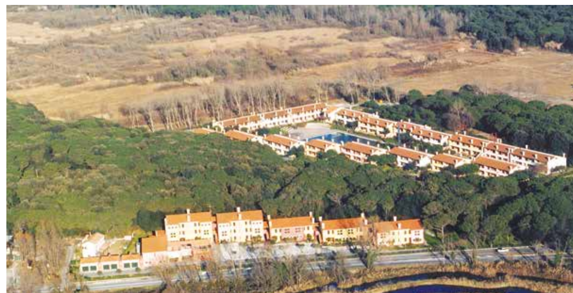
Intervento di 60 alloggi a ROSOLINA (RO) - 1999
