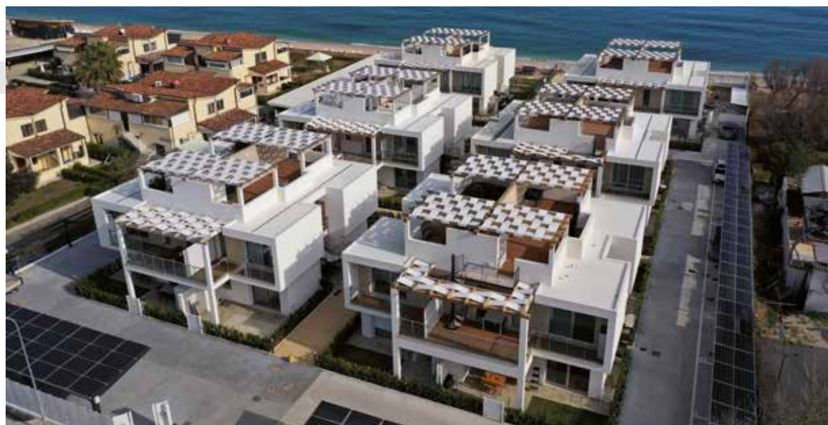
Intervento di 14 alloggi a PORTO RECANATI (MC) - 2019
