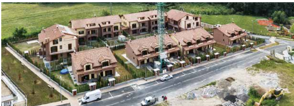
Complesso residenziale a DOLZAGO (LC) - 2009
