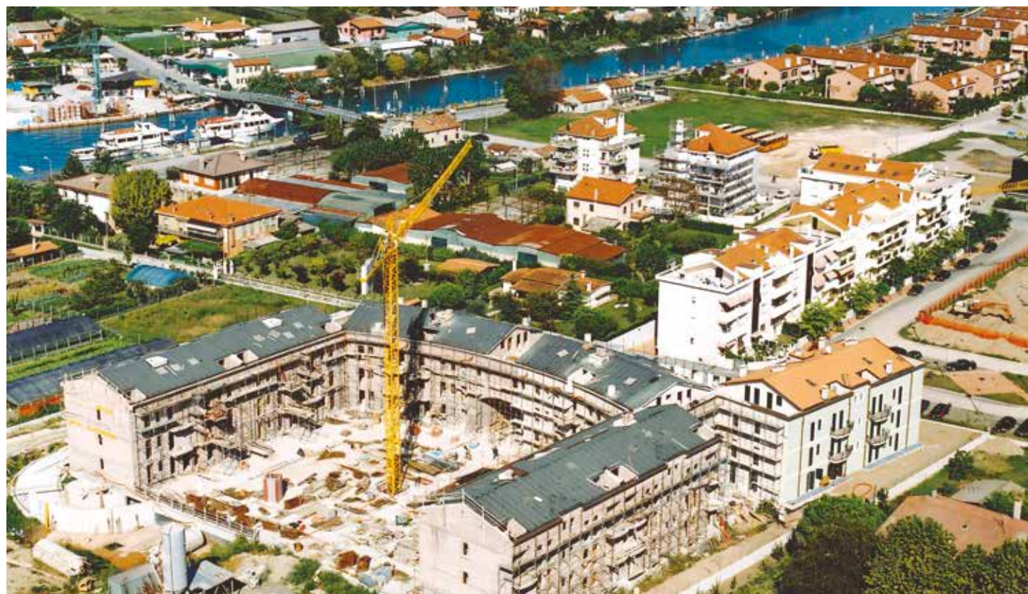
Intervento di 70 alloggi a JESOLO (VE) - 2001
