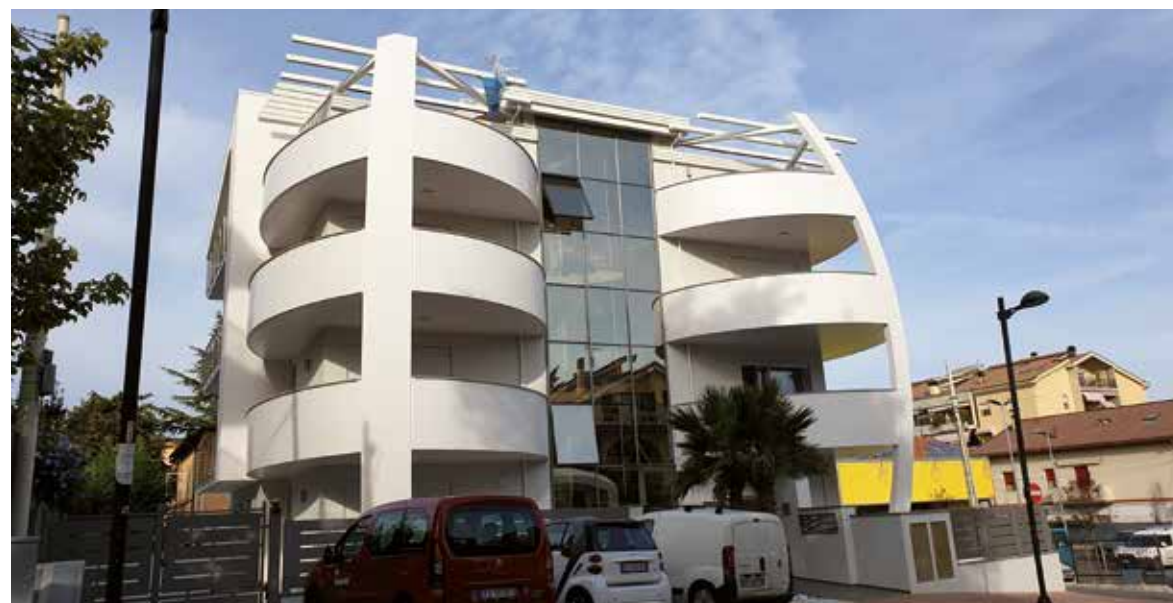
Edificio residenziale a PESCARA - 2016
