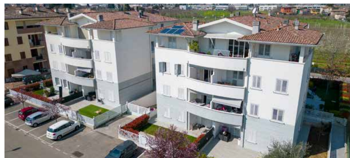
Intervento 2 palazzine a Vignola (MO) - 2022
