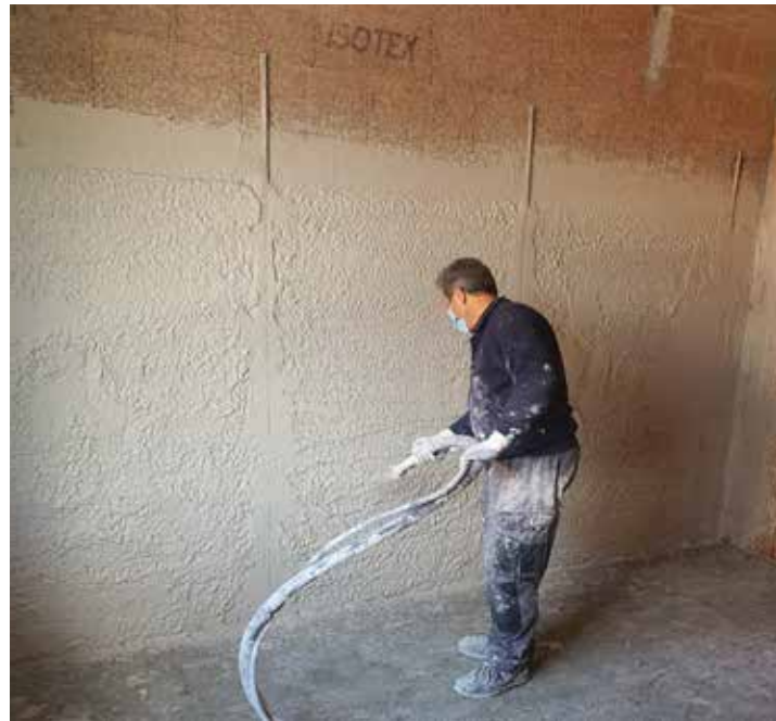
Applicazione di intonaci premiscelati e tradizionali
