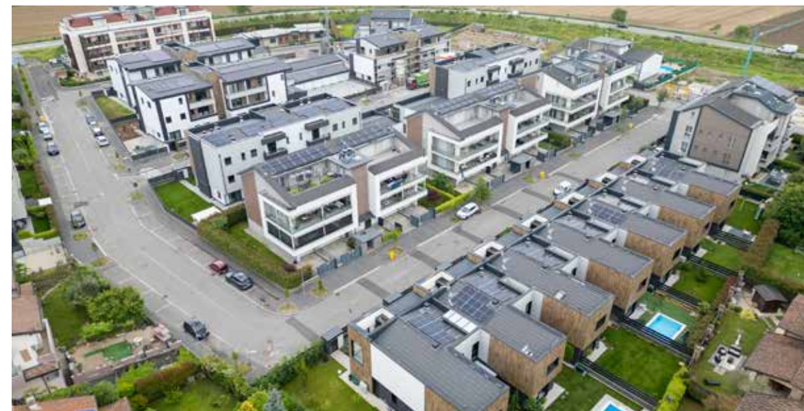
Palazzina 38 alloggi - Buccinasco (MI) - 2024
