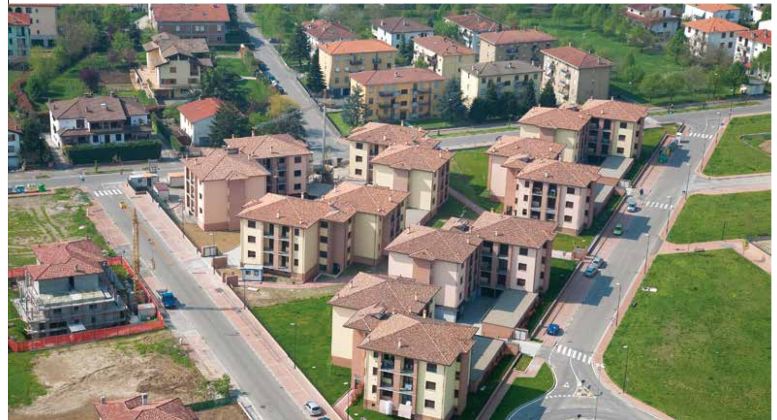
Quartiere residenziale di 7 palazzine a NOCETO (PR) - 2006
