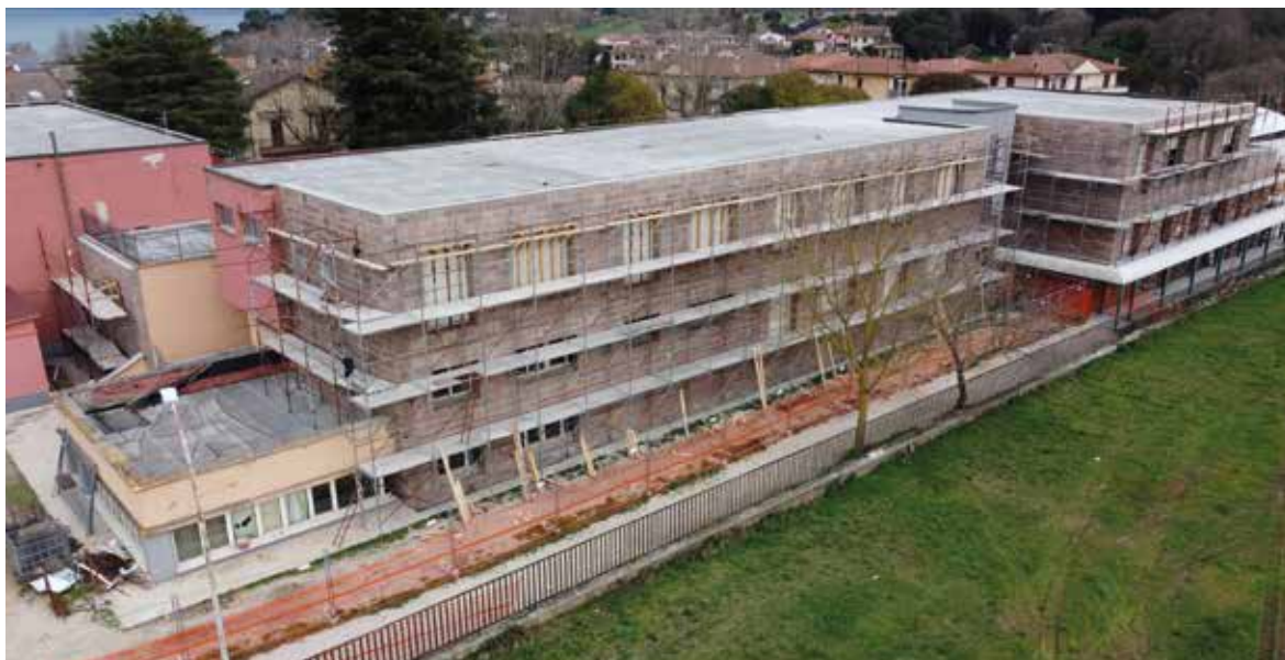
Scuola primaria "Dante Alighieri" a Marta (VT), Realizzata con esoscheletro
