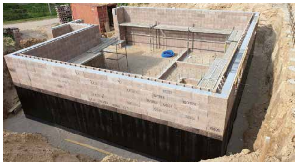
Villa unifamiliare realizzata in LITUANIA- 2019
