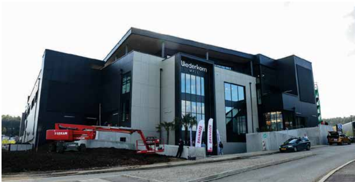
Centro commerciale di 37.000 mq a Niederkorn (LUSSEMBURGO) - 2025
