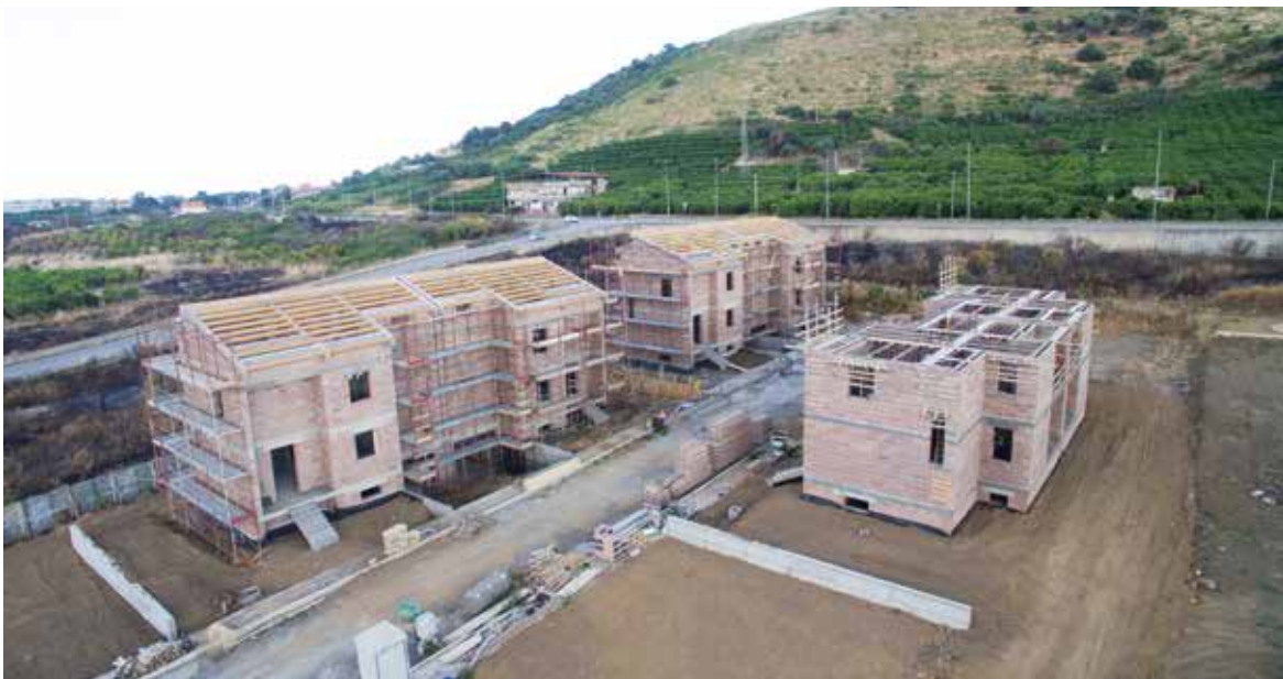
Intervento di 3 palazzine a PALAGONIA (CT) - 2017
