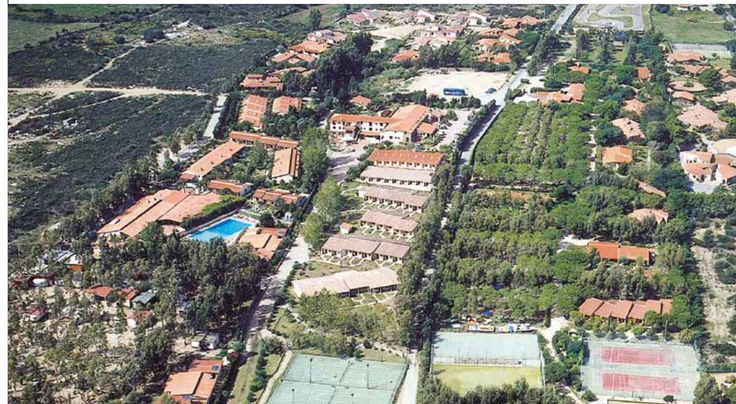
Intervento a SAN TEODORO (NU) - 2000
