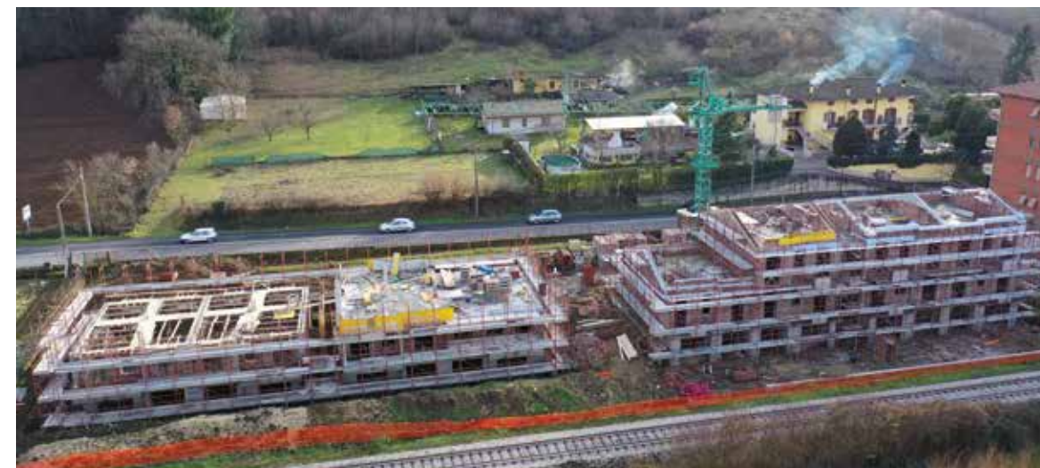
Intervento di 2 palazzine 16 alloggi a RIETI - 2020
