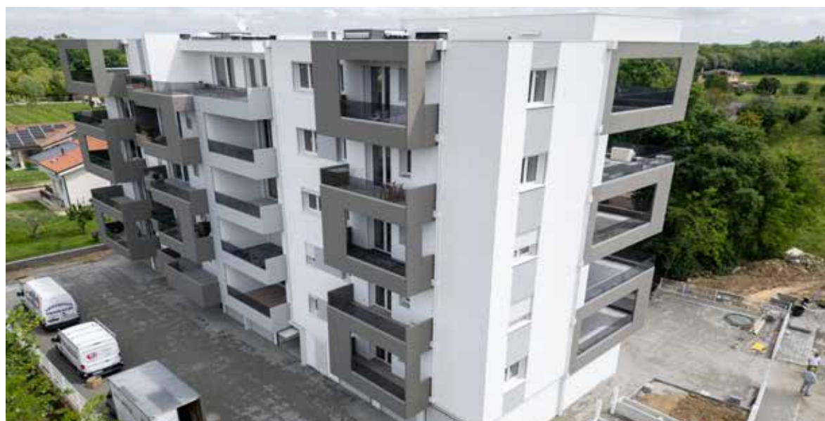
Palazzina 6 piani Residence Pegaso a Favaro Veneto - 2024
