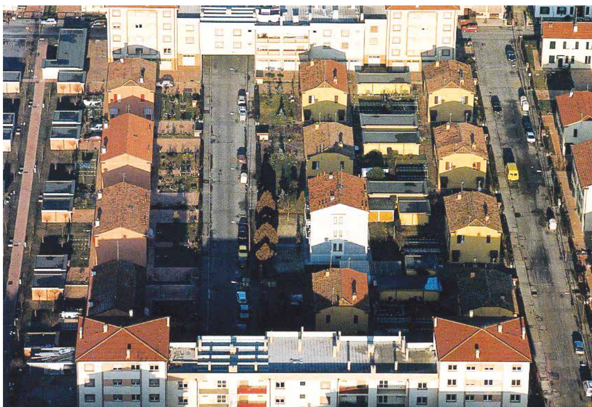
Realizzazione di condomini a FERRARA - 1999
