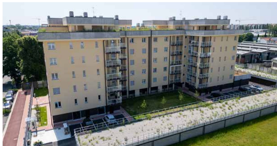
Palazzina 38 alloggi - Buccinasco (MI) - 2024
