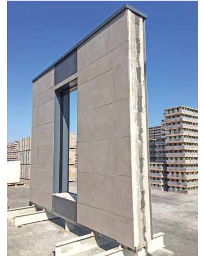
Lato esterno con rivestimento in ceramica e lato interno con parete ventilata
