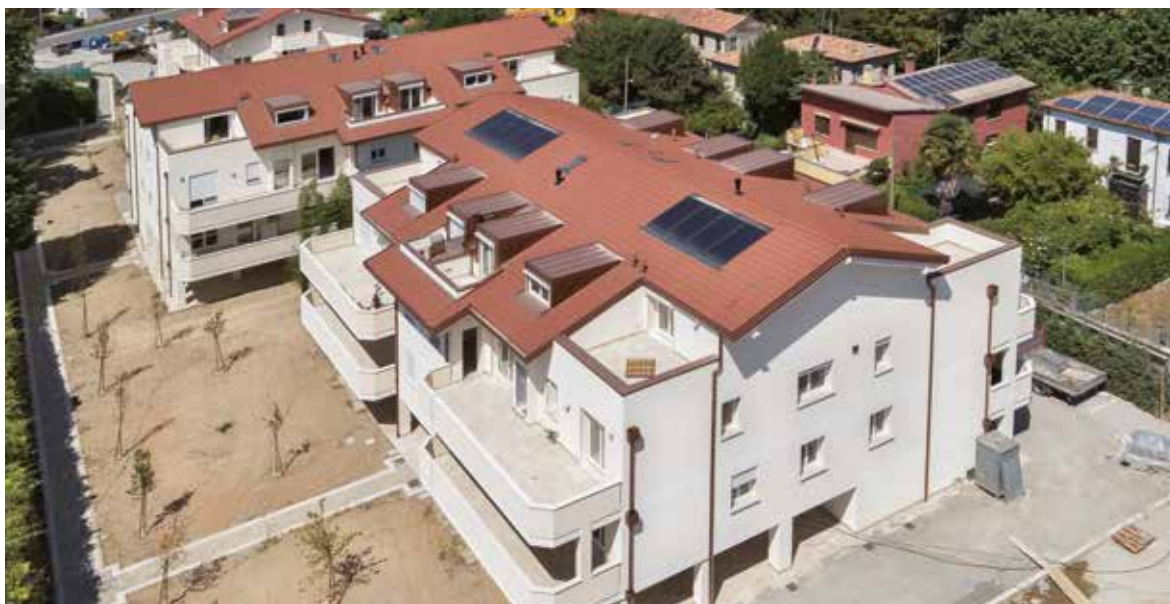
Intervento di 2 palazzine a PADOVA - 2011
