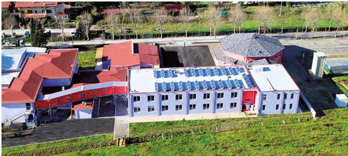
Edificio Scolastico a MASSAROSA (LU) - 2015
