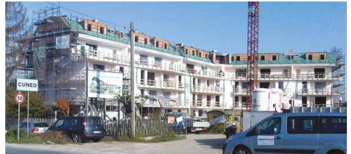
Intervento 36 alloggi a CUNEO - 2010
