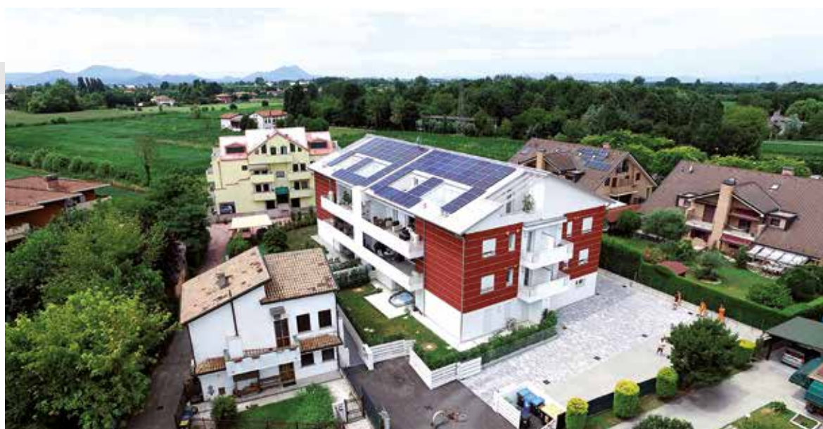
Edificio residenziale di 15 alloggi a MONTA' (PD) - 2017
