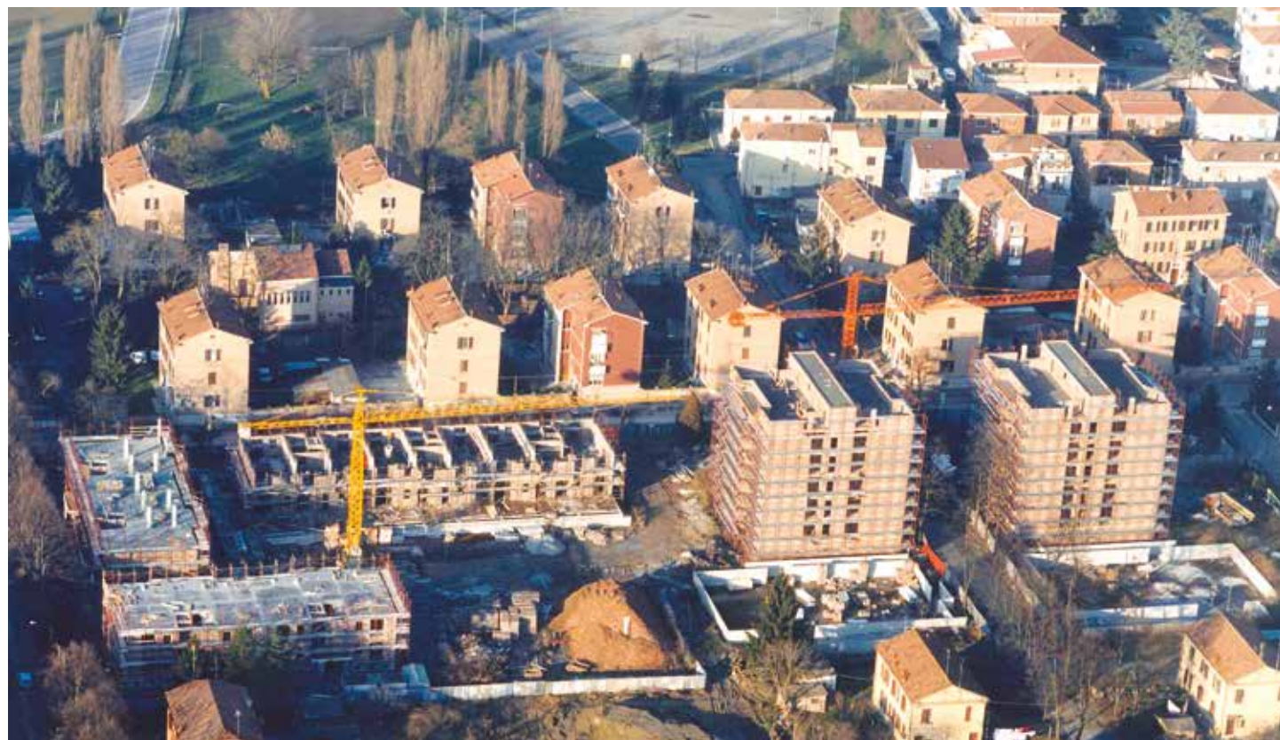
Costruzioni a più piani realizzate a FERRARA - 1990
