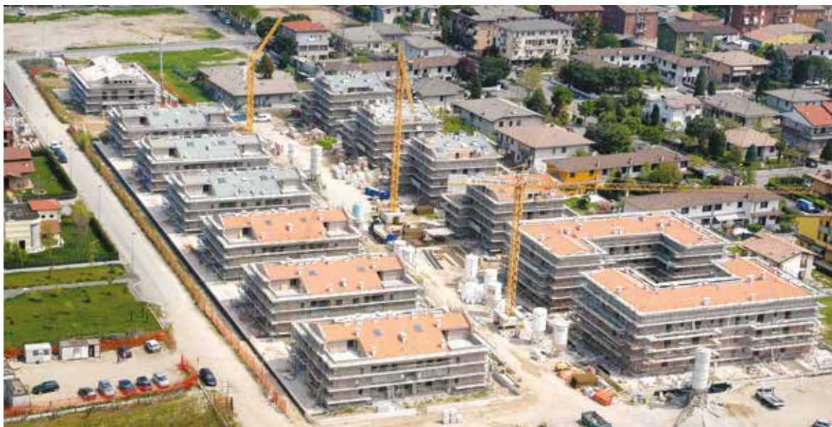
Quartiere residenziale di 162 alloggi a VERONA - 2005
