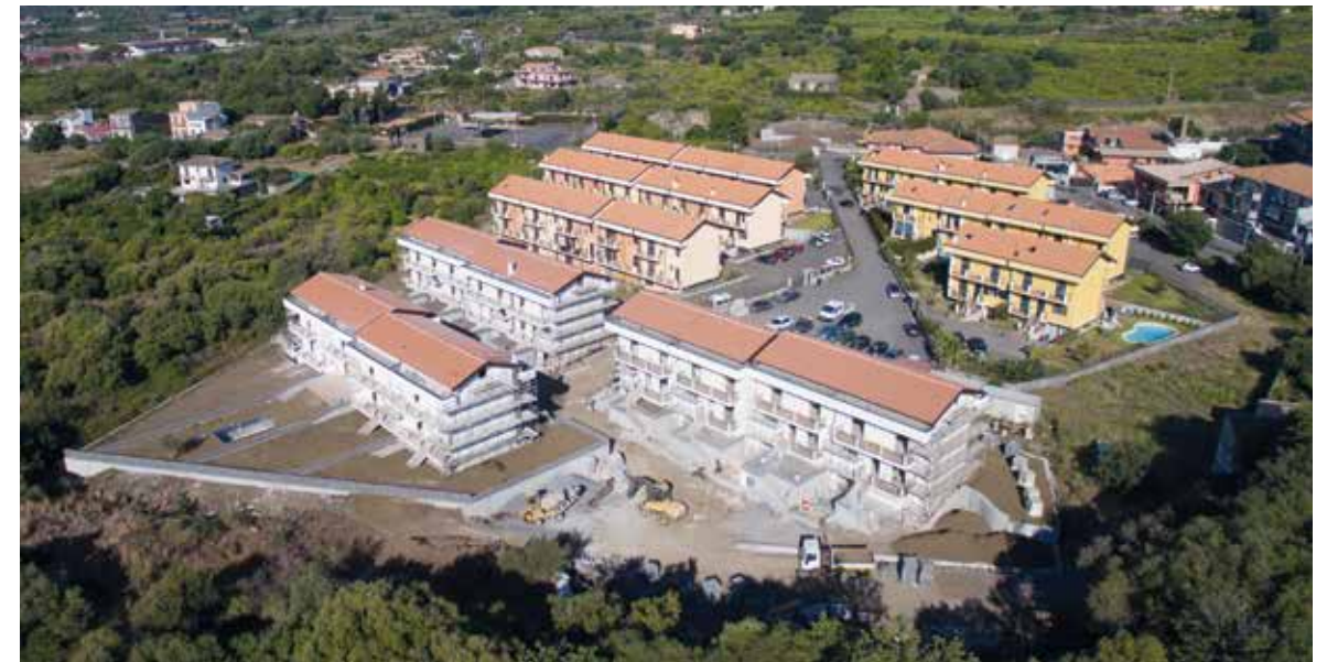
Quartiere residenziale ad ACIREALE (CT) - 2017
