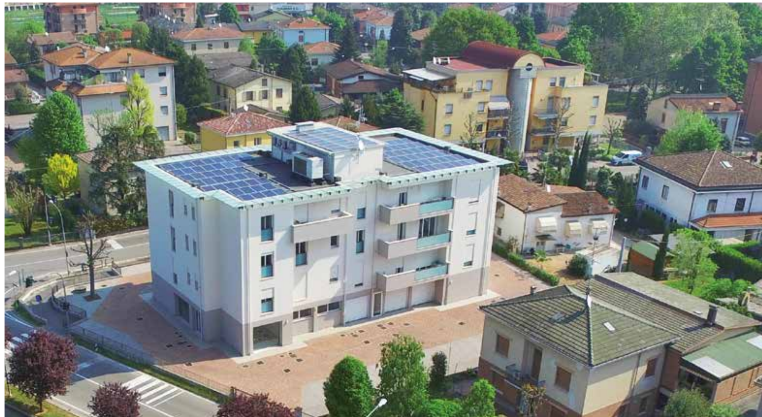
Edificio residenziale a CAVEZZO (MO) - 2016
