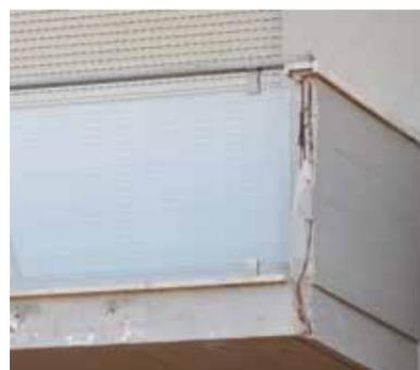
Esempio di una costruzione degli anni '80 - Parapetti in cemento con parti deteriorate
