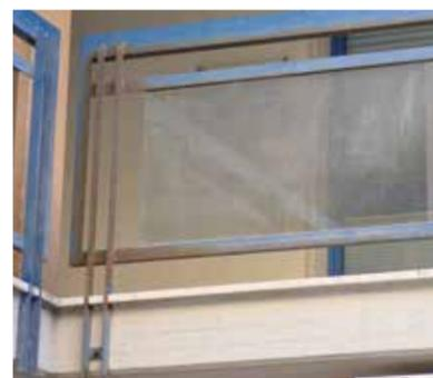
Esempio di una costruzione degli anni '80 - Parapetti in ferro con parti arrugginite
