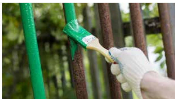
Manutenzione con trattamenti specifici antiruggine per i comuni parapetti in metallo, per evitare che gli stessi vengano corrosi dal tempo, perdendo bellezza e sicurezza.
