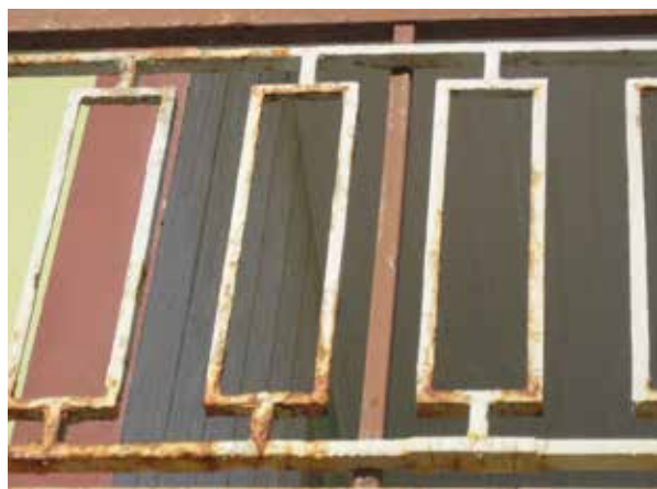
Manutenzione con trattamenti specifici antiruggine per i comuni parapetti in metallo, per evitare che gli stessi vengano corrosi dal tempo, perdendo bellezza e sicurezza.
