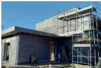
**1** Applicazione dei profili paraspigolo **BIO-PROFIL** con rete integrata a protezione di sporgenze e rientranze. Rinforzare gli angoli dei fori.
