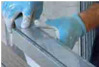
**2** Fissare i *profili a "U"* a terra seguendo il tracciato. Incollare sul dorso delle stesse la *guarnizione* mono o biadesiva antirumore.
