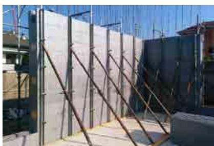
**8** Raggiunta l'altezza di piano, utilizzare l'attrezzatura per la messa a piombo della parete. I puntelli sono posti ogni 80 cm e fissati con coclee.
