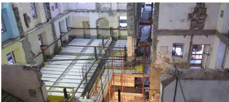
Sostituzione di vecchi solai con Termosolaio per la riqualificazione statica ed energetica
