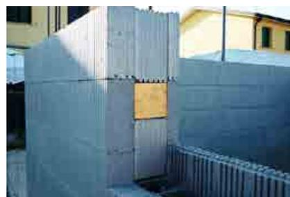
**6** Utilizzare gli *Inserti in EPS/Legno* a creazione della spalletta delle aperture inserendoli dall'alto nella fessura a coda di rondine.
