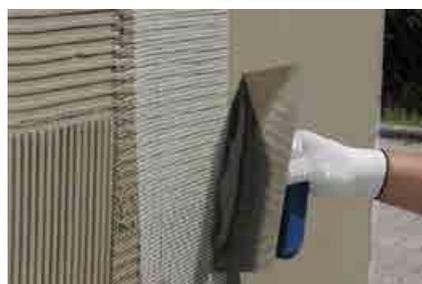
**4** Applicare la seconda mano di rasante **BIO-RAS** a copertura completa della rete. Lisciatura a frattazzo.
