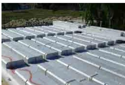
**8** Proseguire con la posa del ferro delle corree di ripartizione. Il ribassamento del pannello viene già effettuato in stabilimento.
