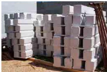
**1** I pannelli giungono in cantiere "a misura" e dello spessore adeguato alla luce da coprire. I pannelli sono identificati con sigla alfanumerica.
