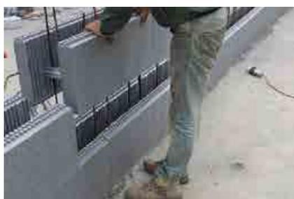
**7** Proseguire con i corsi successivi sfalsando i giunti. Piccole pressioni manuali assicurano l'incastro con i blocchi sottostanti.
