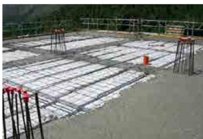
**11** Proseguire il getto del calcestruzzo con la soletta (cappa) di completamento e livellare a staggia per una superficie complanare.
