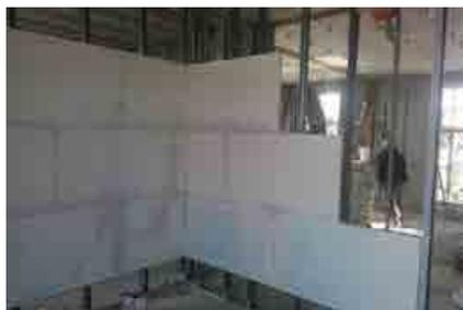
**10** Proseguire con la posa delle lastre superiori sfalsando i giunti. Procedere al taglio della lastra con cutter, incidendo due/più volte.
