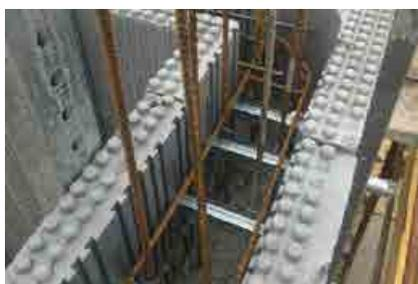
**5** Completare il perimetro fino a chiusura del primo corso. Disporre le armature orizzontali negli alloggiamenti del distanziale.
